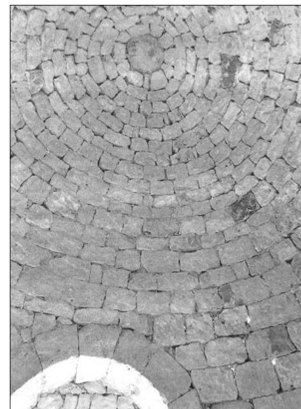
Figura 3. L'intradosso di una vecchia cupola trullana , vista dal basso verso l'alto.
