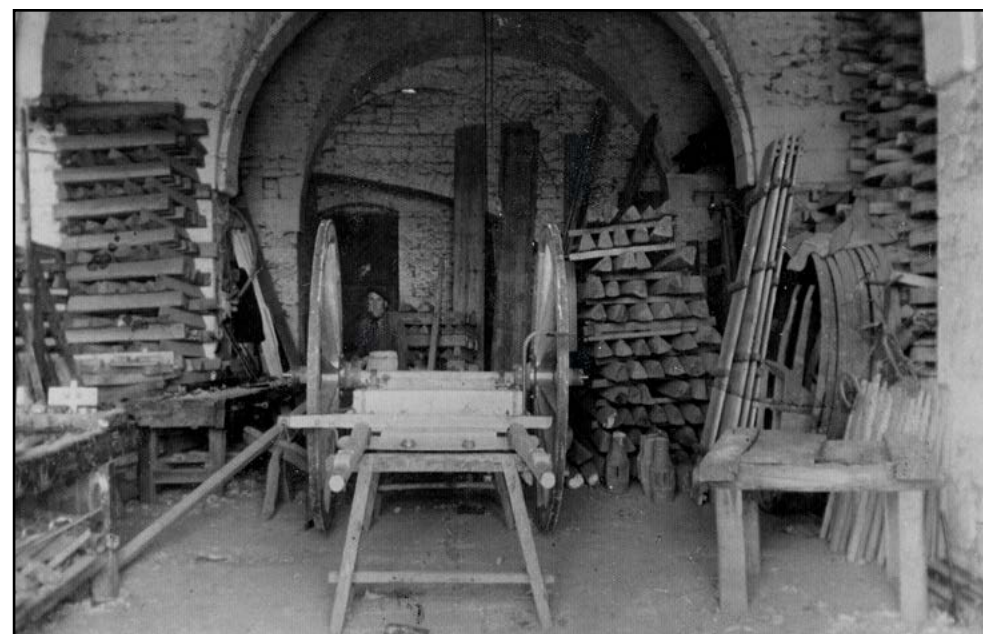
Via Cisternino, reparto falegnameria e installazione.
