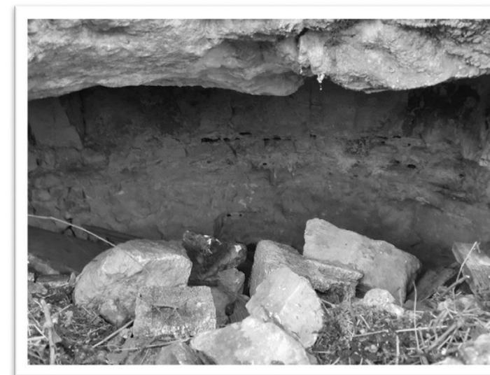
da piazza Palatucci conduce su viale Valle d'Itria, una seconda simile struttura per la raccolta delle acque meteoriche. La prima cisterna risultava completamente riempita di terra, sassi e vari materiali di risulta, nonché di acqua che evidenziava l'integrità e impermeabilità delle stesse; mentre la seconda, era colma solo di acqua piovana.
