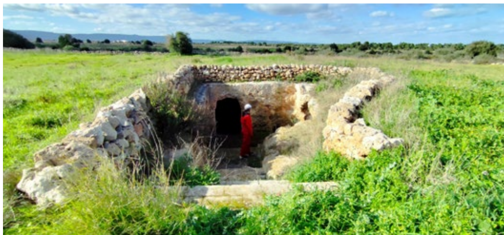
Fig. 4 Esterno del trappeto allo stato attuale (foto di D.V.P.).
