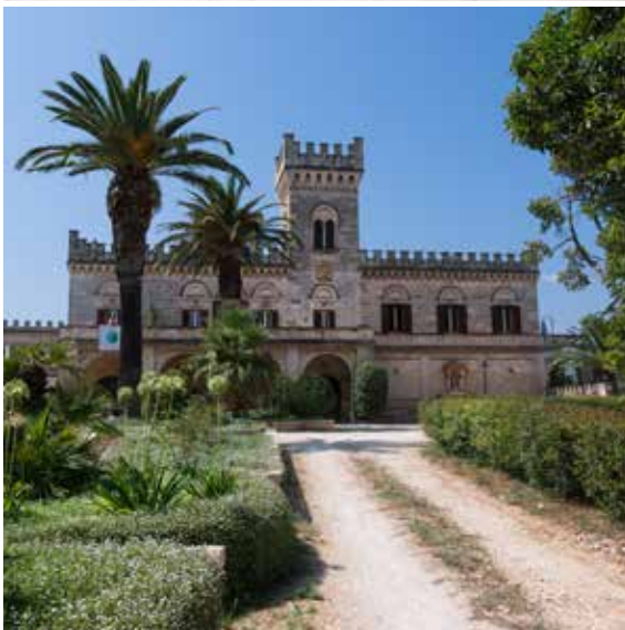
FASANO Masseria Salamina
